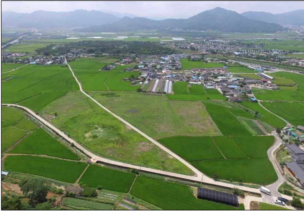
사진 12. 경주 천관사지 전경
